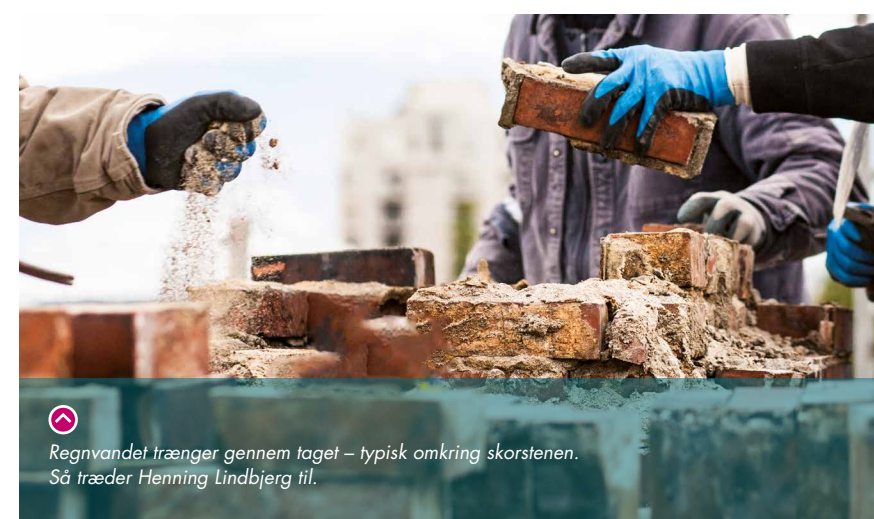
Huse og villaer fra 60-erne og 70-erne er tit bygget af for dårlige mursten, og så opstår skaderne. Henning Lindbjerg på arbejde i Vancouver.
